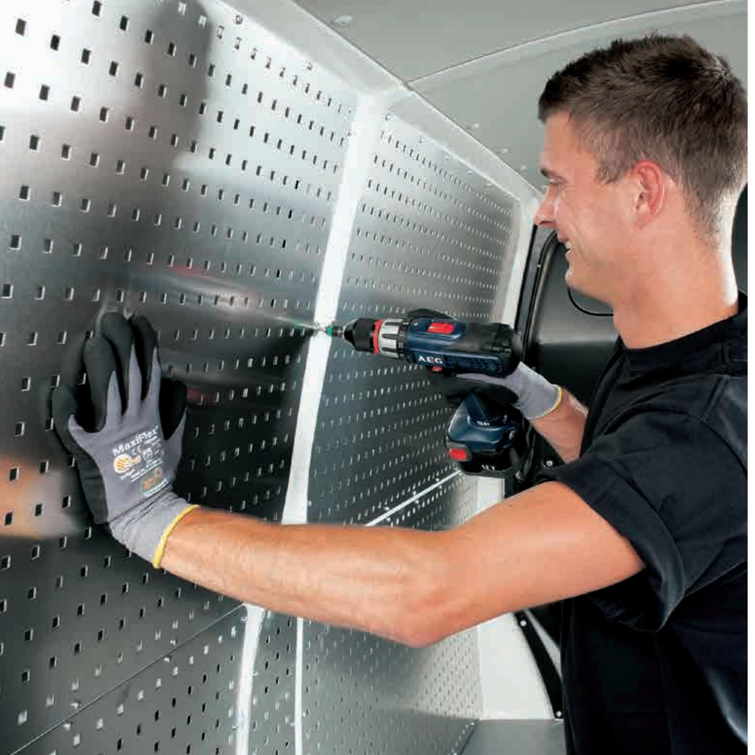
Auf Wunsch rüstet ALUCA Ihr Fahrzeug mit Bodenplatten, Seitenwandverkleidungen und Ladungssicherungselementen aus.
